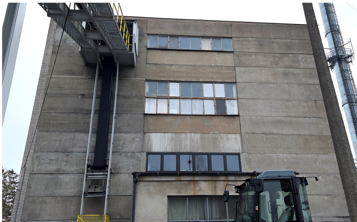
Zdjęcie nr 6 – elewacja południowa
