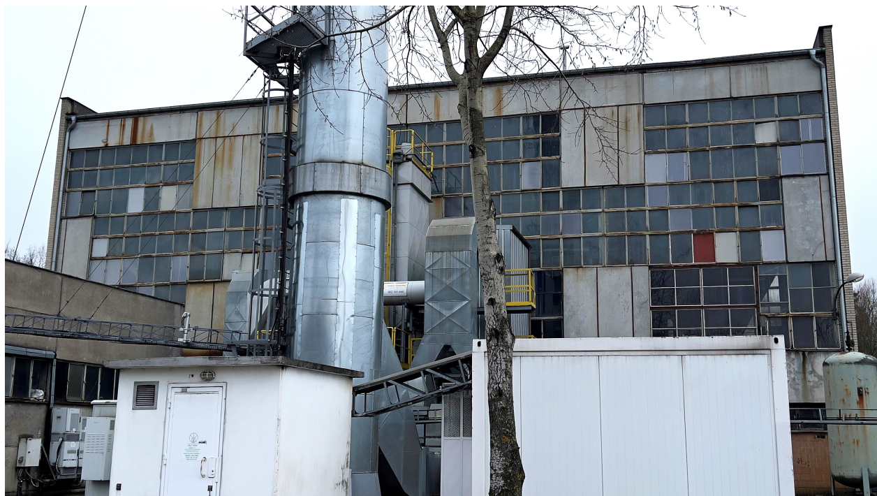
Zdjęcie nr 2 - elewacja wschodnia
