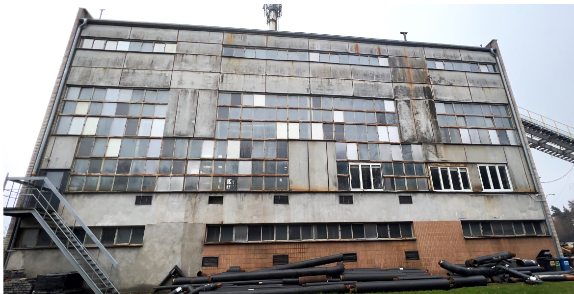
Zdjęcie nr 7 – elewacja zachodnia
